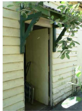
P1230636 Laundry door & canopy
