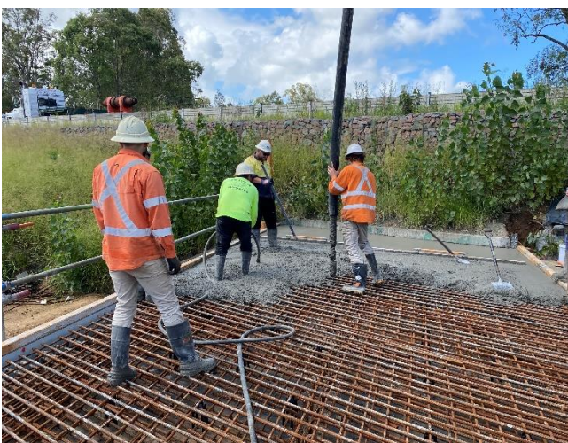
Concrete pour of culvert roof
