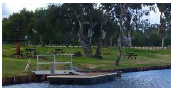
Urana Aquatic Centre Enhancement, Urana
