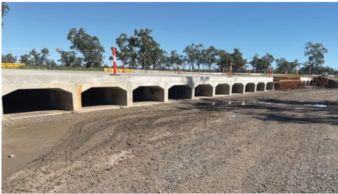
Top slab pour on the 20 box cell culvert
