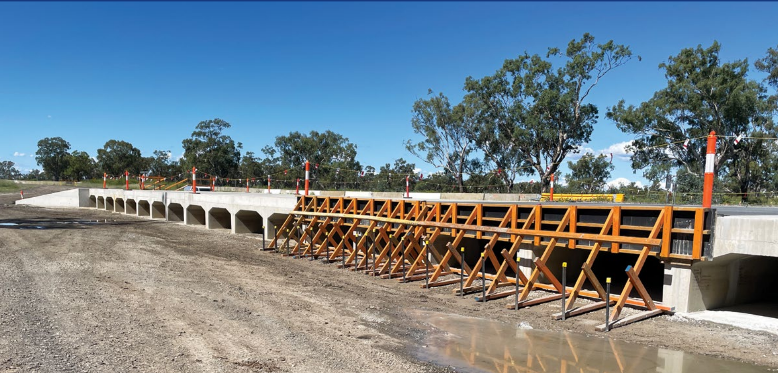
Final top slab pour on the 20 box cell culvert
